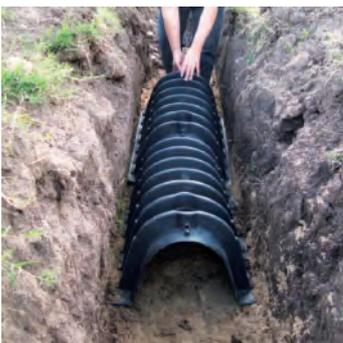
Cámara de infiltración
